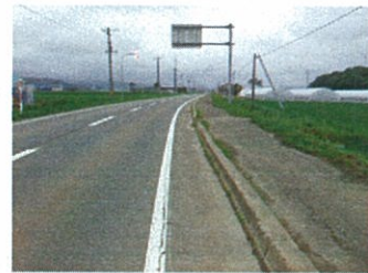
道道今金北檜山線歩道
