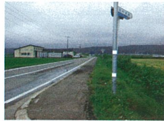
田代通線歩道
