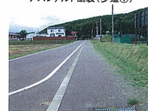
アスファルト舗装(歩道①)
