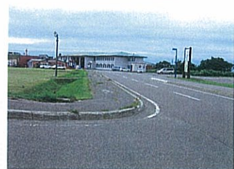
アスファルト舗装(歩道②)
