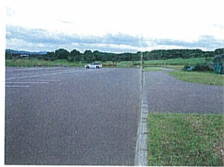
アスファルト舗装(駐車場①)
